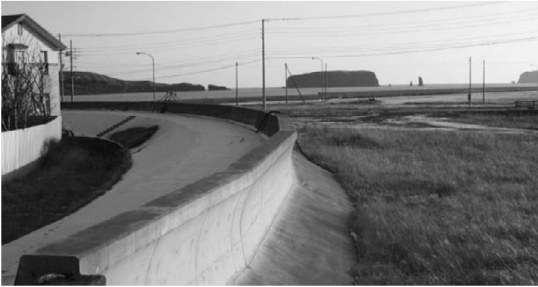
嵩上げ工事が待たれる防潮堤
