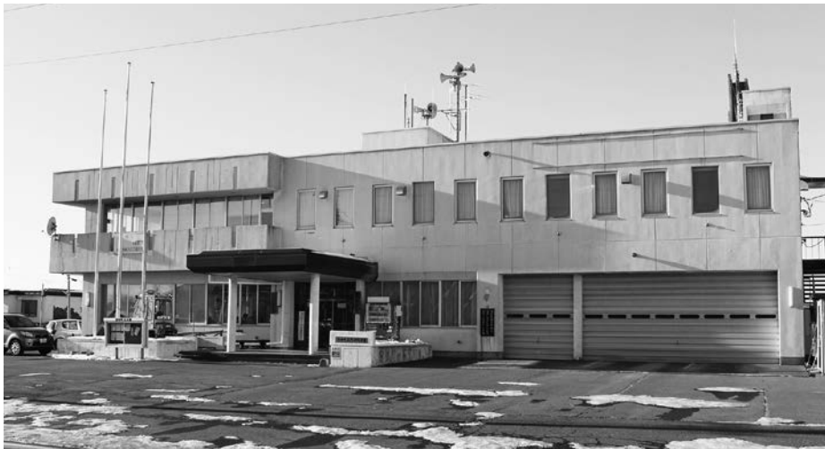
耐震補強を要する茶内支所
