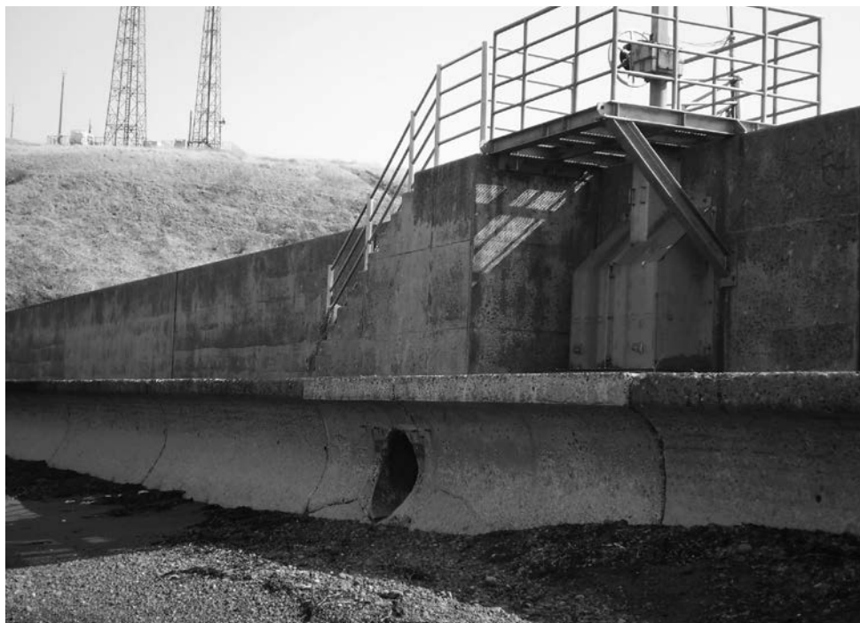
手動式の樋管
