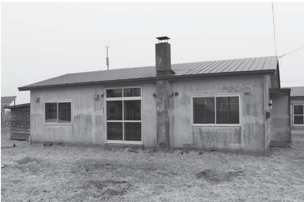
改修されるお試し住宅
