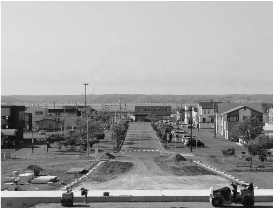
完成間近の避難道(霧多布中央通)
