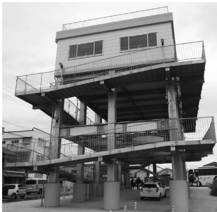
室内避難場所を備えた津波避難タワー (和歌山県)
