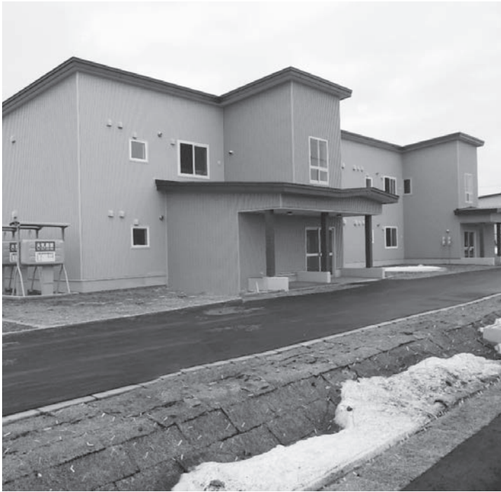
4年度に完成した茶内団地（2棟目）
