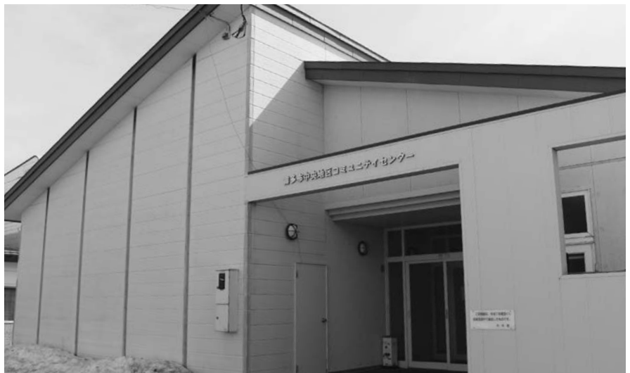
塗装工事が施されるコミセン
