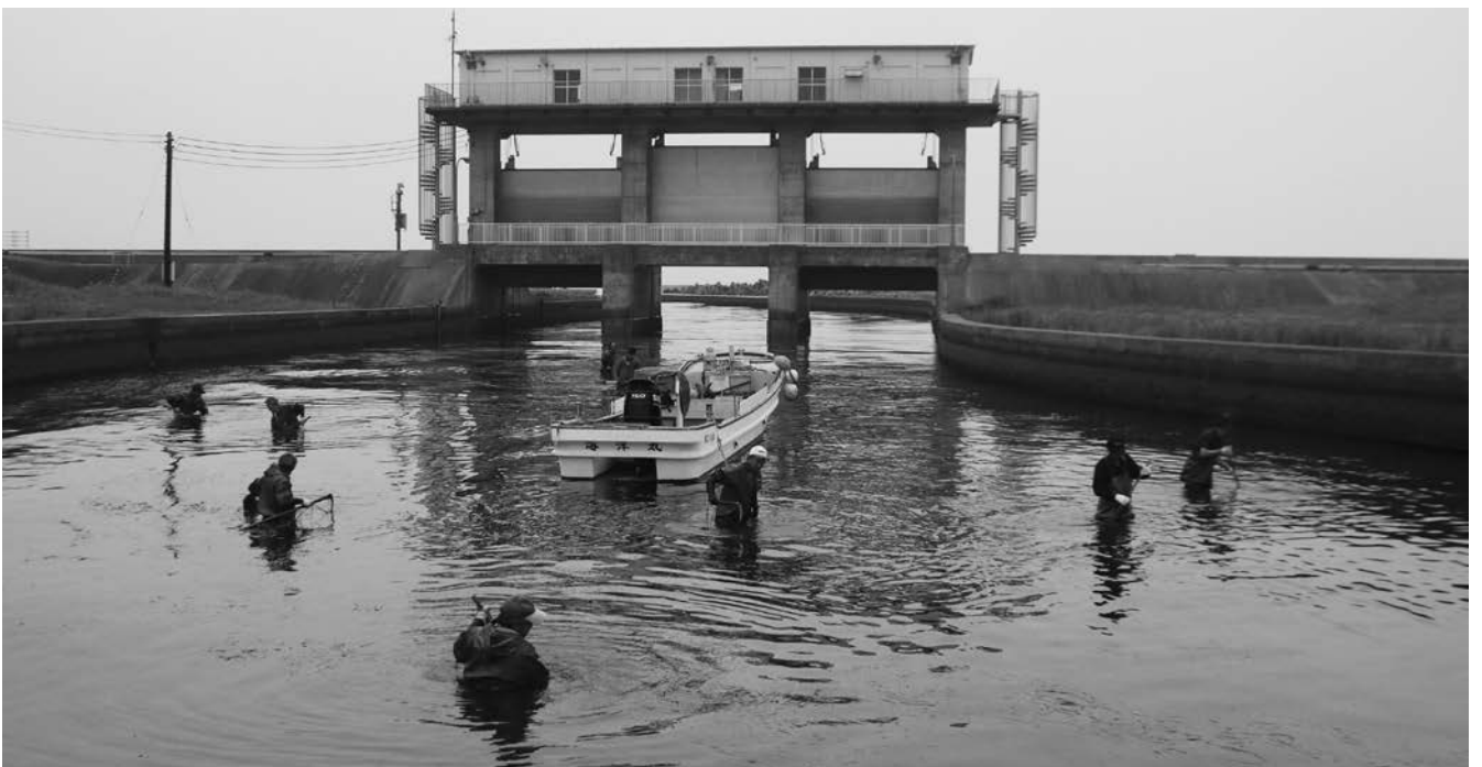
地域住民による航行に支障を来す藻の除去作業（新川水門）
