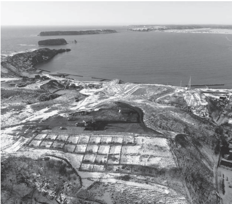
庁舎建設地の造成工事（ドローン撮影）
