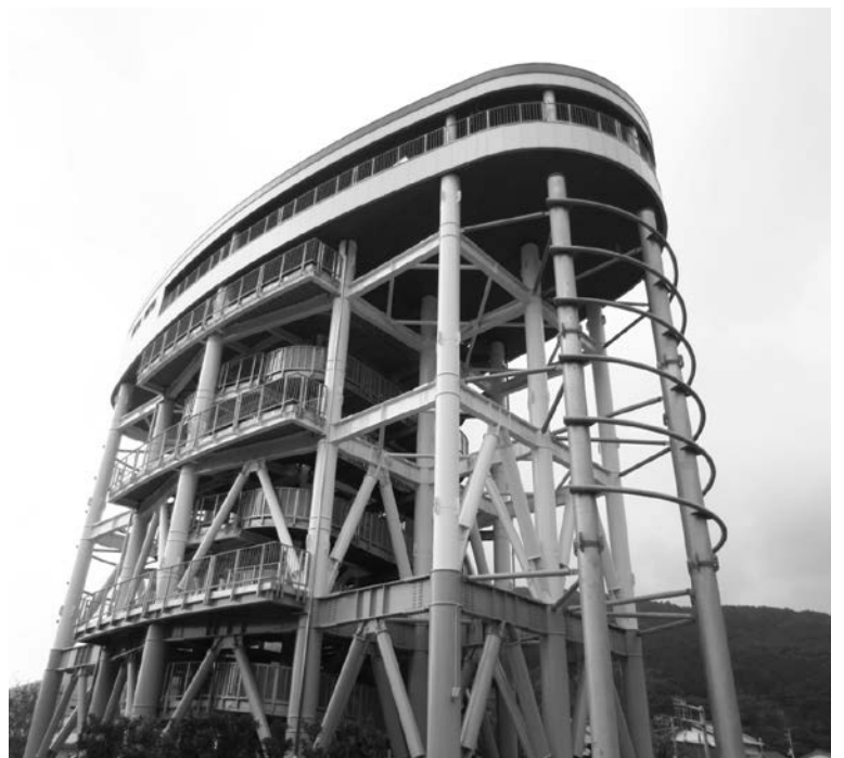
高知県黒潮町佐賀地区の津波避難タワー
