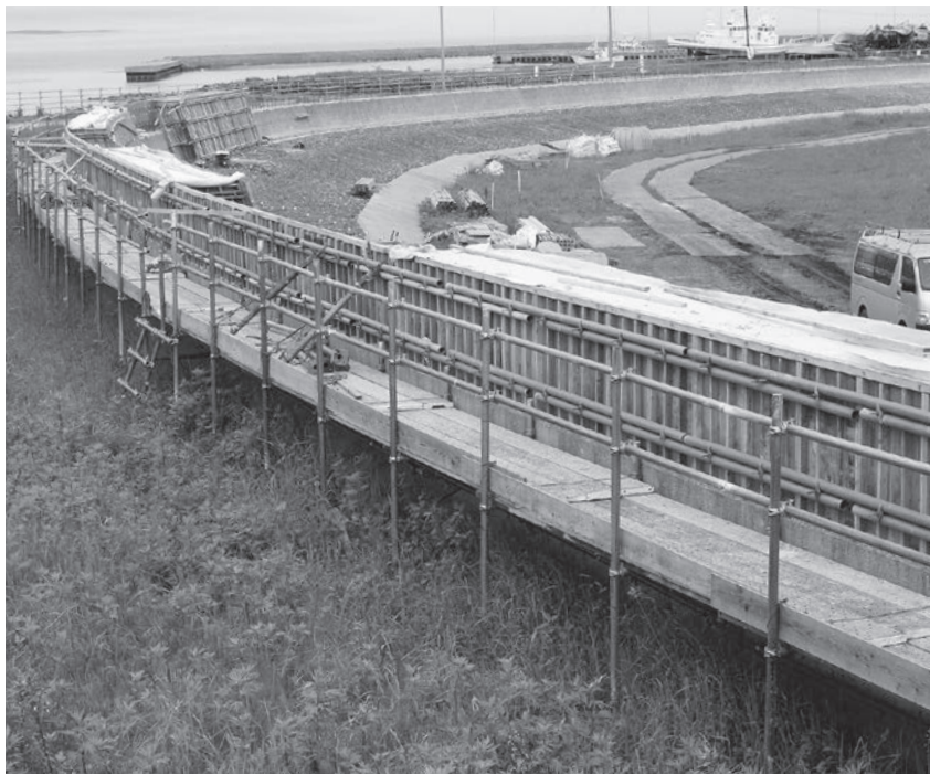
嵩上工事が進む防潮堤
