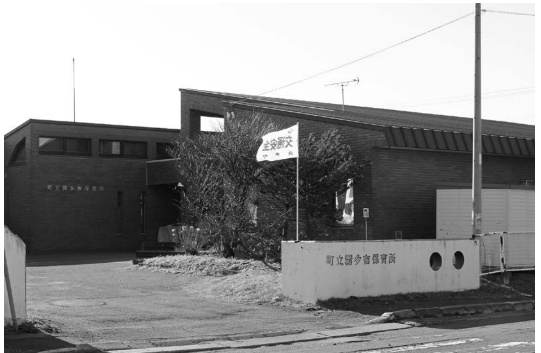
移転が望まれる霧多布保育所
