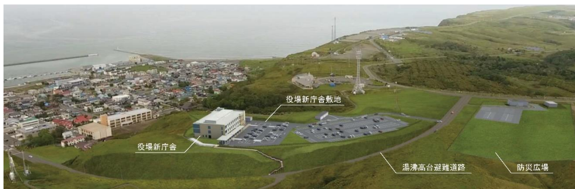
図 4-6 役場新庁舎外観、配置写真
