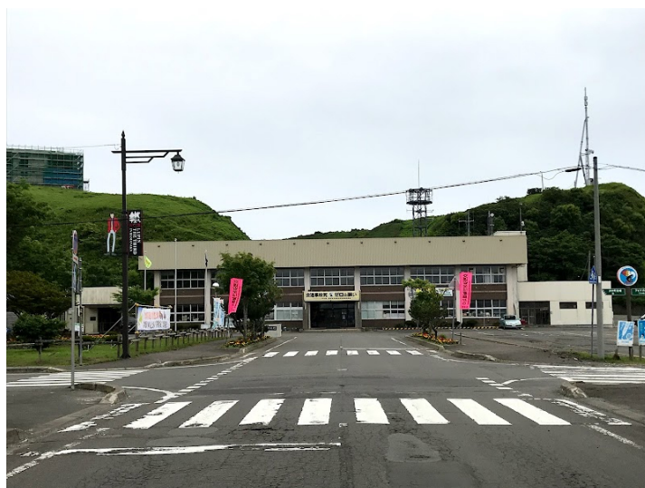
図 4-5 役場旧庁舎外観写真
