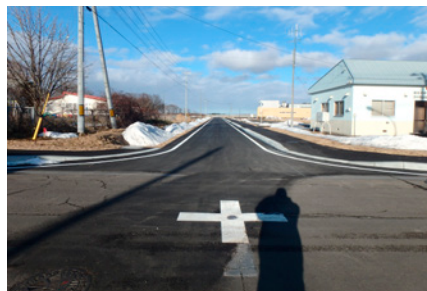
浜中桜4号通 改良舗装工事
