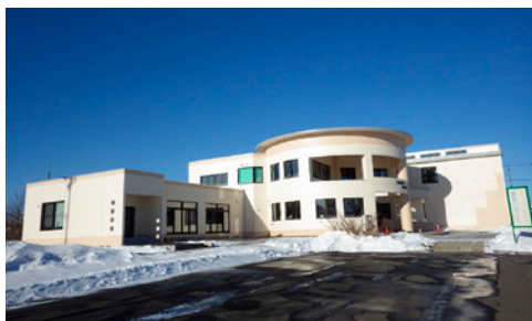
浜中農村環境改善センター 改修工事
