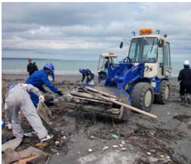
赤石建設(株)によるゴミ収集作業の様子
