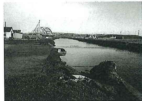
港湾施設の被害
